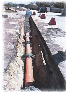
Figura n.º 1 e n.º 2 – Instalação do coletor de saneamento
