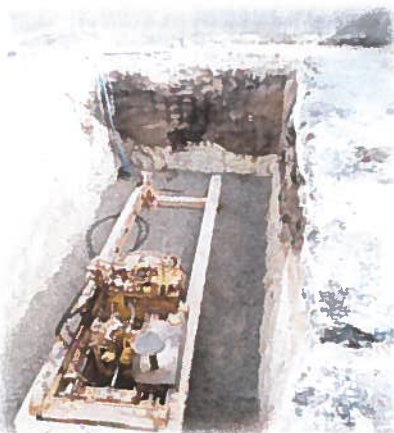
Figura n.º 5 e n.º 6 – Perfuração horizontal para atravessamento ferroviário da linha do Minho para instalação do coletor de saneamento
