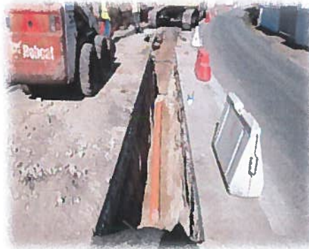
Figura n.º 10 – Instalação do coletor de saneamento
