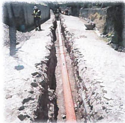
Figura n.º 7 e n.º 8 – Execução de estação elevatória e instalação do coletor de saneamento
