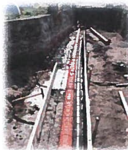
Figura n.º 3 e n.º 4 – Execução de estação elevatória e instalação do coletor de saneamento
