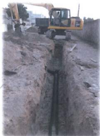
Figura n.º 9 e n.º 10 – Instalação de coletor de águas residuais coletores
