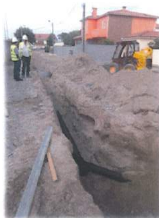
Figura n.º 9 e n.º 10 – Instalação de coletor de águas residuais coletores
