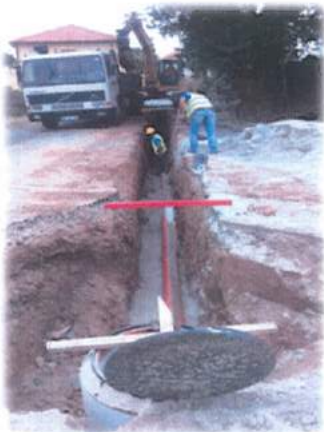
Figura n.º 13 e n.º 14 – Instalação de coletor de águas residuais e ramal
