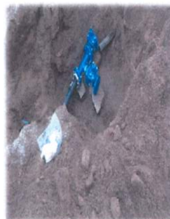
Figura n.º 13 e n.º 14 – Instalação de ramal de águas residuais e nó de água
