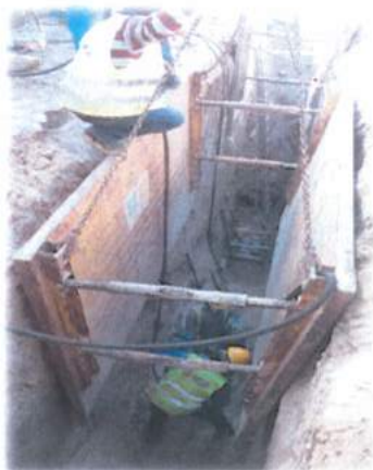
Figura n.º 17 e n.º 18 – Instalação de coletor residual e queda guiada em caixa de visita
