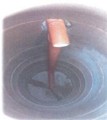
Figura n.º 17 e n.º 18 – Instalação de coletor residual e queda guiada em caixa de visita
