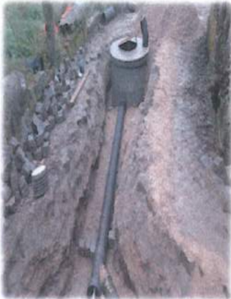
Figura n.º 5 e n.º 6 – Instalação de ramal e coletor de saneamento
