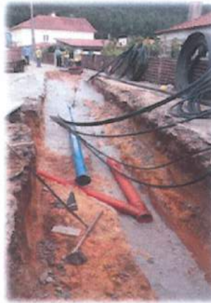
Figura n.º 11 e n.º 12 – Instalação de coletor de águas residuais coletores
