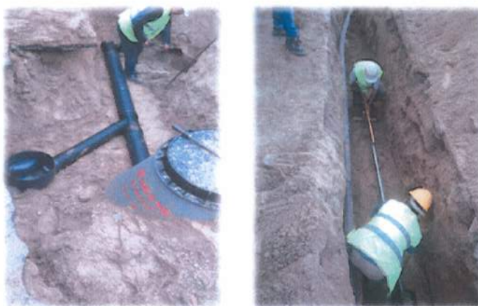
Figura n.º 1 e n.º 2 – Instalação de ramal e coletor de saneamento
