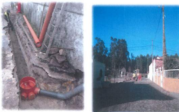
Figura n.º 3 e n.º 4 – Instalação de ramal e abertura de vala para instalar o coletor de saneamento
