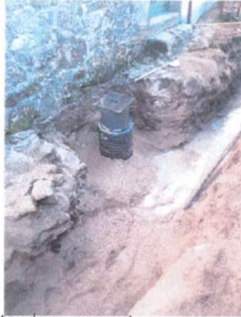
Figura n.º 5 e n.º 6 – Instalação de ramal e coletor de saneamento
