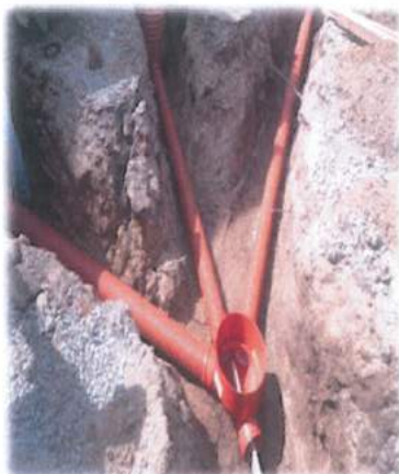
Figura n.º 13 e n.º 14 – Instalação de ramal de águas residuais e nó de água
