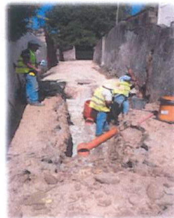
Figura n.º 13 e n.º 14 – Instalação de coletor de águas residuais e ramal
