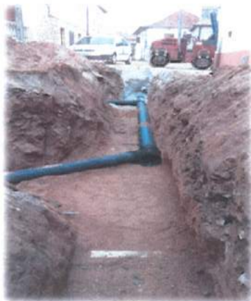
Figura n.º 7 – Instalação de coletor de saneamento
