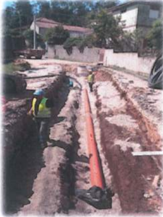
Figura n.º 11 e n.º 12 – Instalação de coletor de águas residuais coletores
