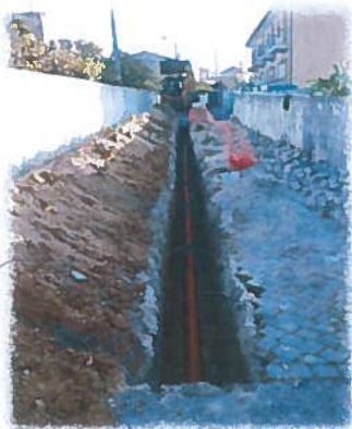
Rede residual na travessa das louras, Santa Marta de Portuzelo
