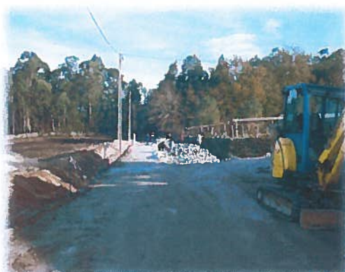
Trabalhos de pavimentação em cubo
