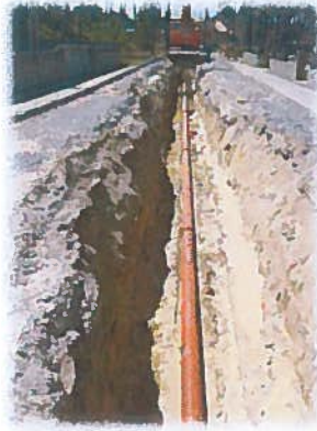
Instalação do coletor de águas residuais
