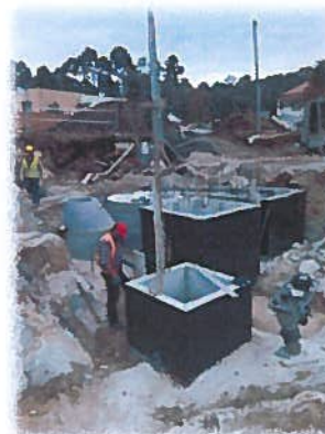
Acabamentos na Estação Elevatória
