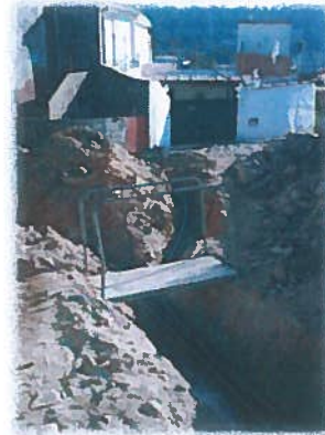
Instalação da conduta de elevatória residuais
