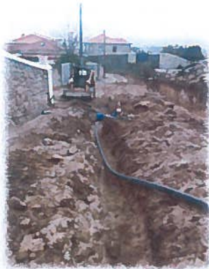
Instalação conduta de água
