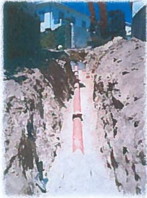
Instalação de rede de saneamento
