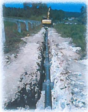
Instalação de coletor
