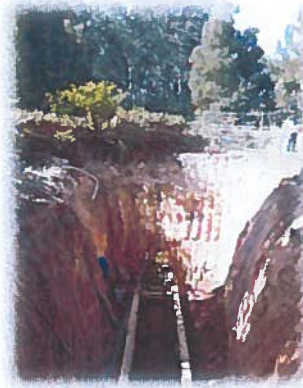
Perfuração horizontal no caminho de ferro
