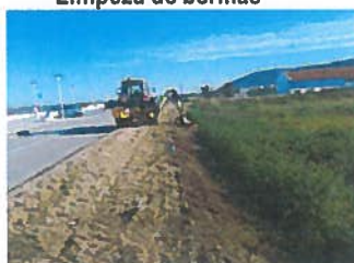
Limpeza de bermas
