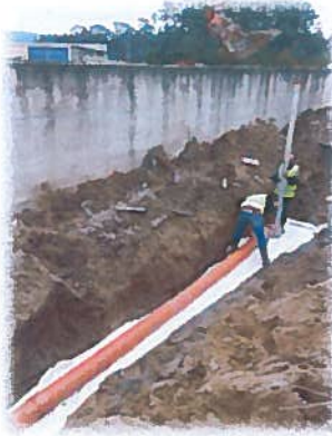
Instalação do coletor de águas residuais
