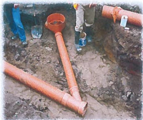
Instalação de ramal de águas residuais
