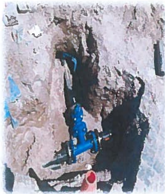
Instalação de nó de ligação da rede de água
