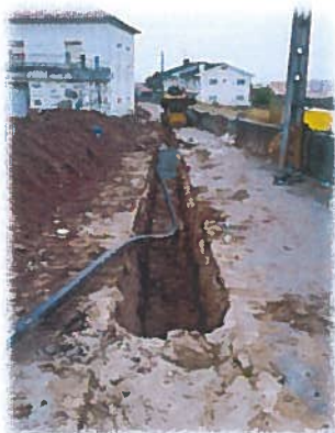
Instalação da conduta de elevatória de saneamento
