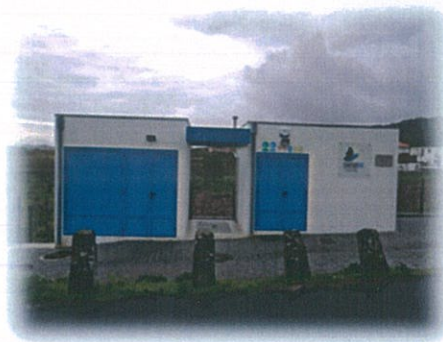
Estação elevatória de águas residuais
