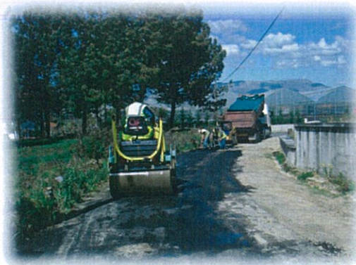
Trabalhos de pavimentação betuminoso
