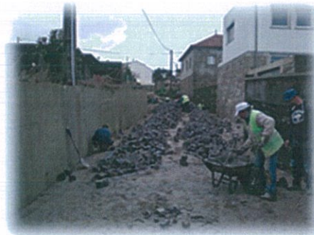
Trabalhos de pavimentação em cubo
