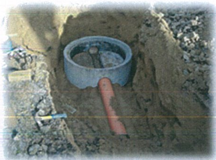
Execução de caixa de visita
