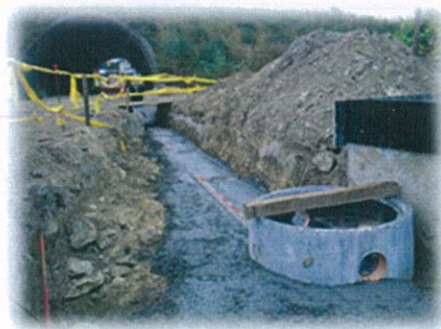
Instalação de rede de saneamento
