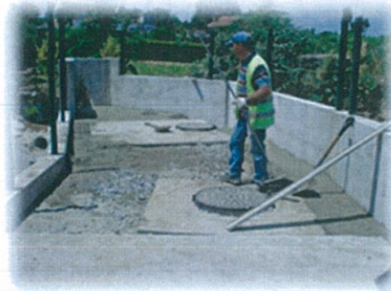
Acabamentos na estação elevatória
