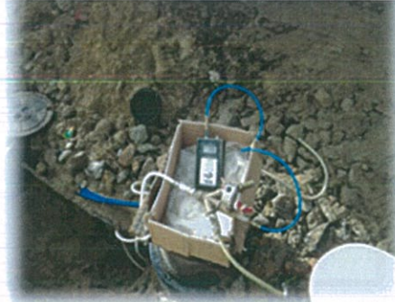
Ensaio de estanquidade à rede residual
