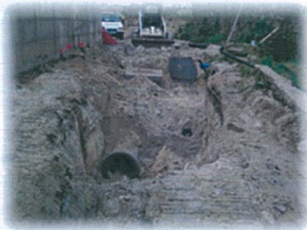
Instalação do coletor pluvial
