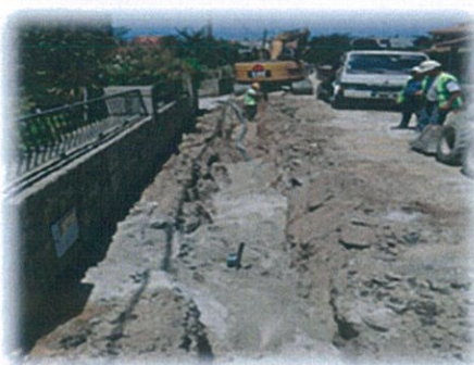
Instalação da conduta de água Couto
