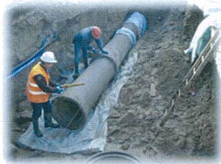
Instalação de coletor pluvial
