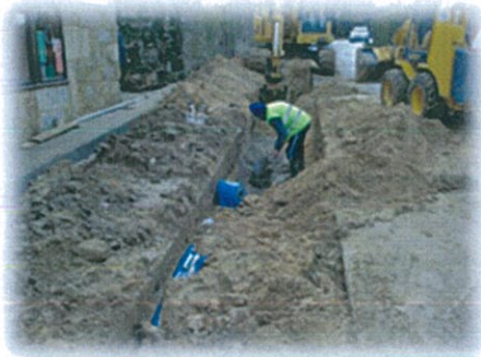
Instalação da conduta de água
