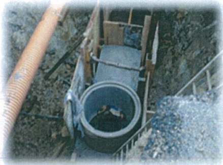
Reposição da mina e execução de acesso mina
