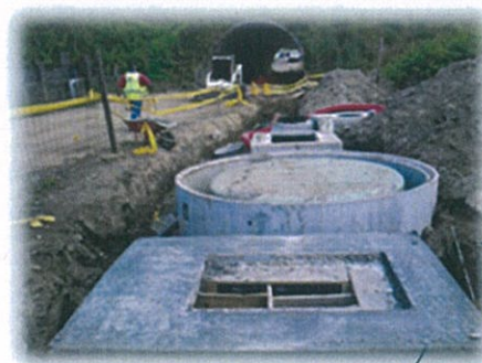
Execução de estação elevatória
