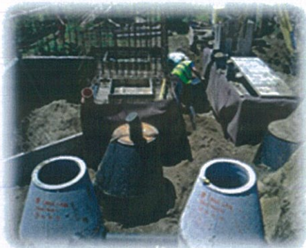
Execução da estação elevatória
