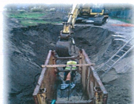
Instalação de coletor de águas residuais
