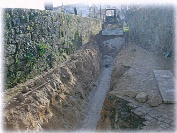
Figura 1 - Instalação de coletor de águas residuais
