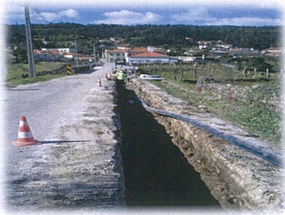
Figura 7 – Instalação de conduta de água
