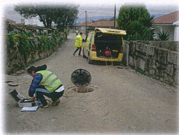
Figura 3- Ensaios de estanquidade à rede residual
