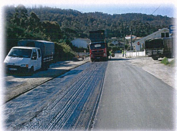
Figura 4 – Trabalhos de pavimentação
