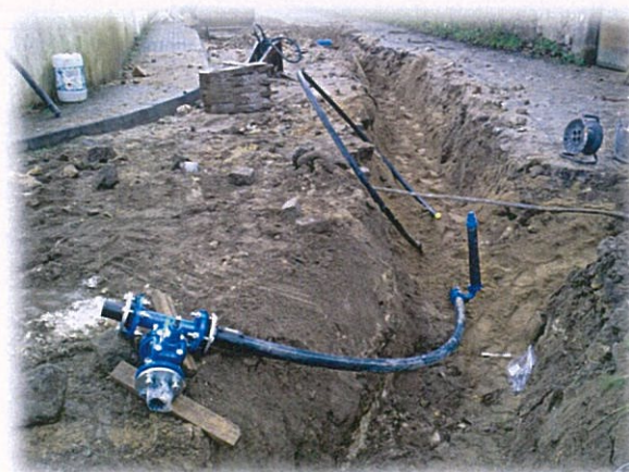
Figura 6 -Execução de ramais e nós da rede de água
