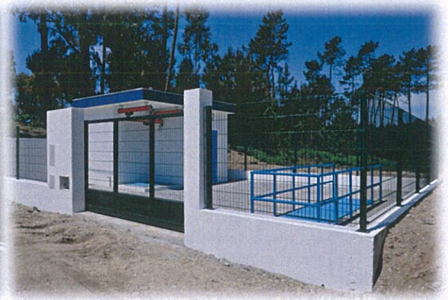
Figura 10 – Estação Elevatória de Alvarães
