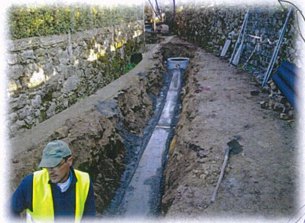
Figura 8 – Betonagem do coletor
