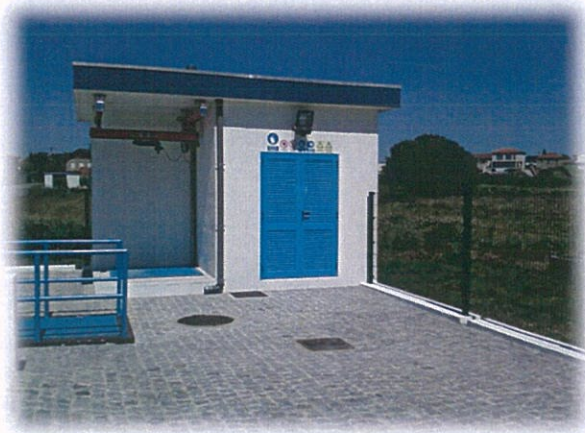
Figura 9 – Estação Elevatória de Chafé
