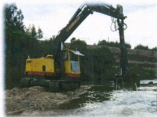
Intervenção na captação de Barroselas
