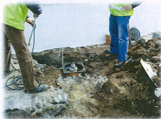
Realização de ensaios de estanquidade
