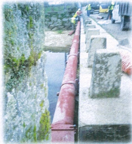
Instalação de tubagem residual em FFD
