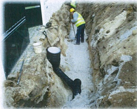
Execução de ramal de águas residuais
