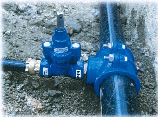
Execução de ramal de água
