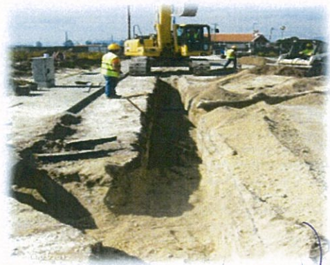
Abertura de vala
