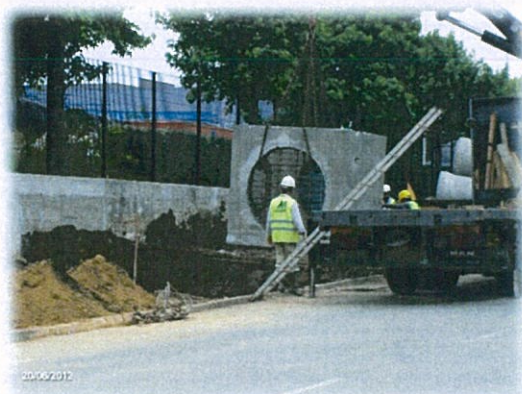
Rede drenagem de águas pluviais - Correção de ligação existente na Zona Industrial do Neiva
