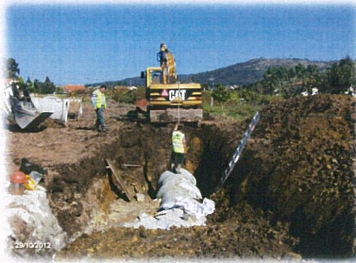
Remodelação do coletor de águas residuais e pluviais no Lugar da Foz – Barroselas
