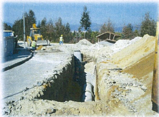
Instalação de coletor pluvial
