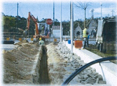
Instalação de conduta de água
