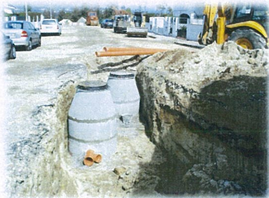
Execução de Caixas de visita
