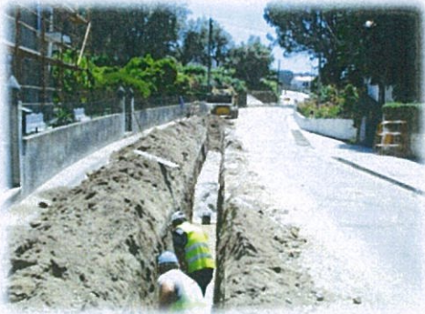
Instalação de coletor de águas residuais
