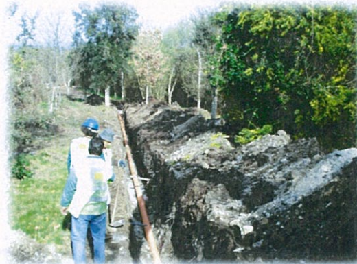
Instalação de coletor de águas residuais
