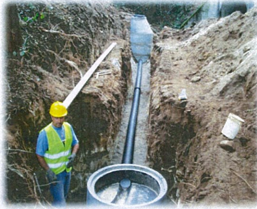
Ampliação das redes de água, águas residuais e pluviais - Ligação de águas residuais – Darque
