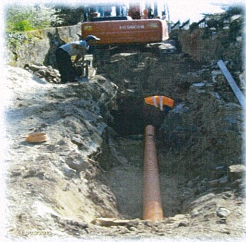
Infraestruturas de água e águas residuais na Rua José Lima – Darque
