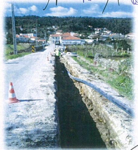
Instalação de conduta de água
