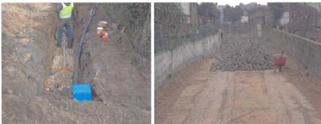
Instalação de conduta de água e pavimentação em cubo
