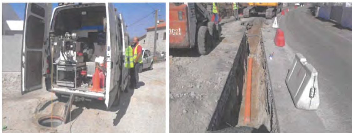
Inspeção vídeo ao coletor e Instalação do coletor de saneamento
