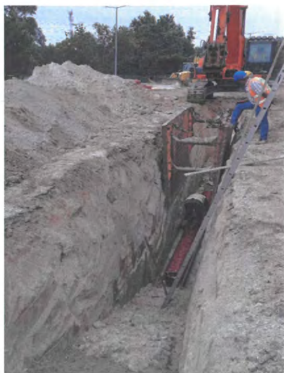
Instalação de águas residuais e abastecimento de água
