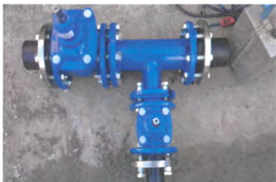
Nó de ligação de rede de abastecimento de água
