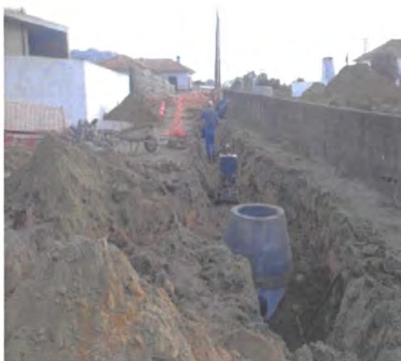
Instalação do coletor de águas residuais
