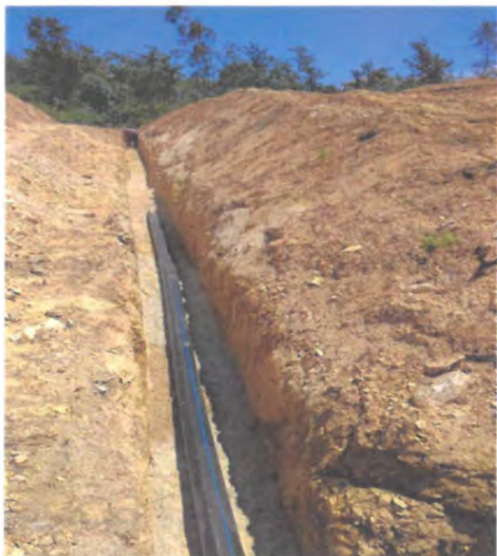
Instalação da conduta
