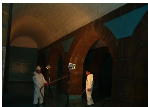
Os SMSB VC desenvolveram ao longo do ano de 2007 diversas acções de limpeza e higienização de reservatórios de água, com recurso a pulverização de ácidos para remoção de incrustações e
